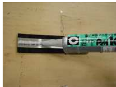
②裏面アルミシートに接着剤を塗布し、 そのまま設置面へ貼付け。
